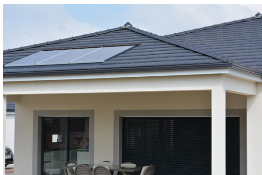
Le kit Solterre PV / Toit en tuiles Giverny couleur Ardoise.
