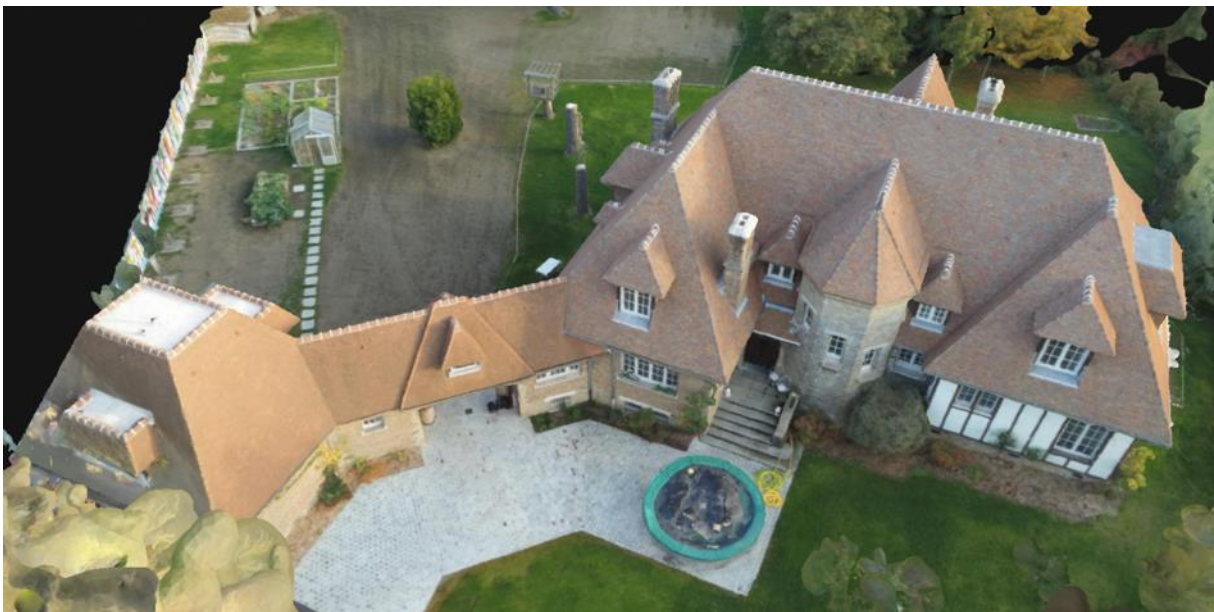
Toiture TERREAL réalisée par la société TOITSUR dirigée par Sylvany Hoarau. Maquette numérique 3D réalisée par WEB2VI.
