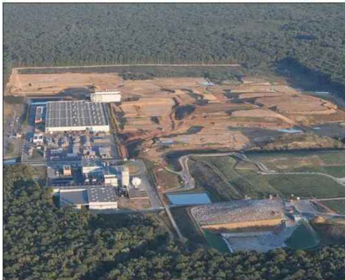
■ L'usine Terreal à l'arrière-plan avec l'usine de tri-méthanisation devant. Photo P. ALIX
