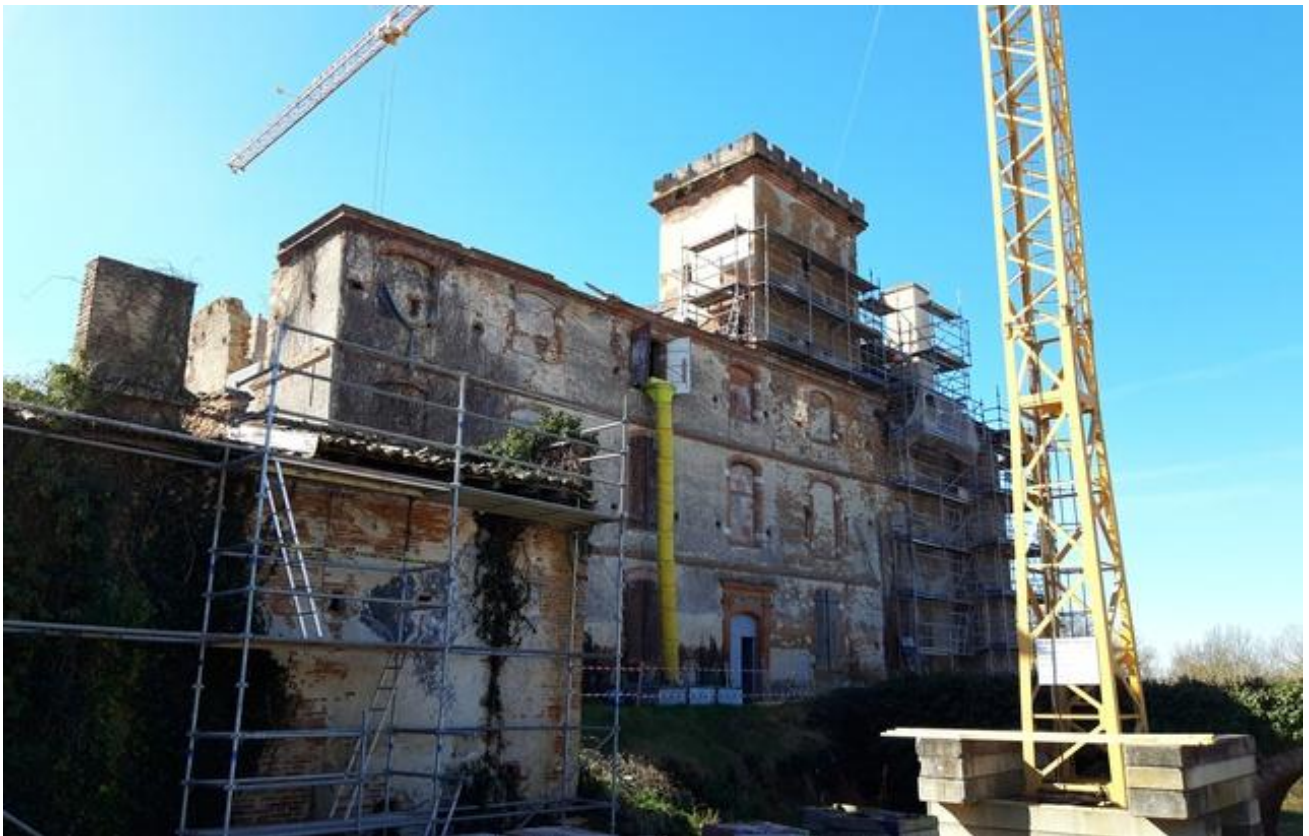
Le château de La Salvetat-Saint-Gilles, près de Toulouse, en plein chantier. — N. Stival / 20 Minutes
