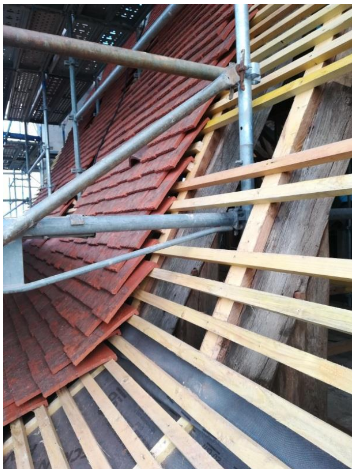
Rénovation de la charpente du pavillon Ouest – ©Mairie de la Salvetat Saint-Gilles
